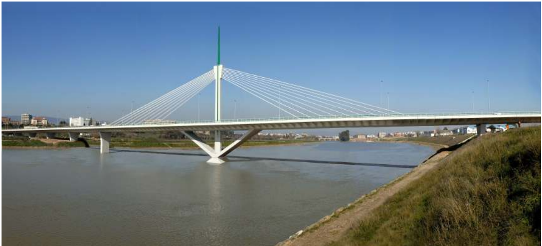
Puente de Córdoba
