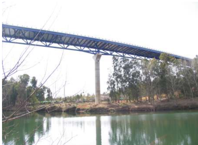
Puente de García Sola
