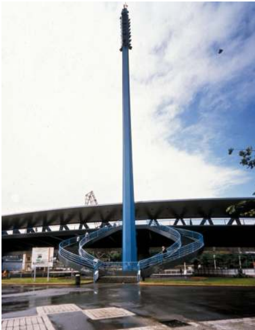
Puente del Euskalduna
