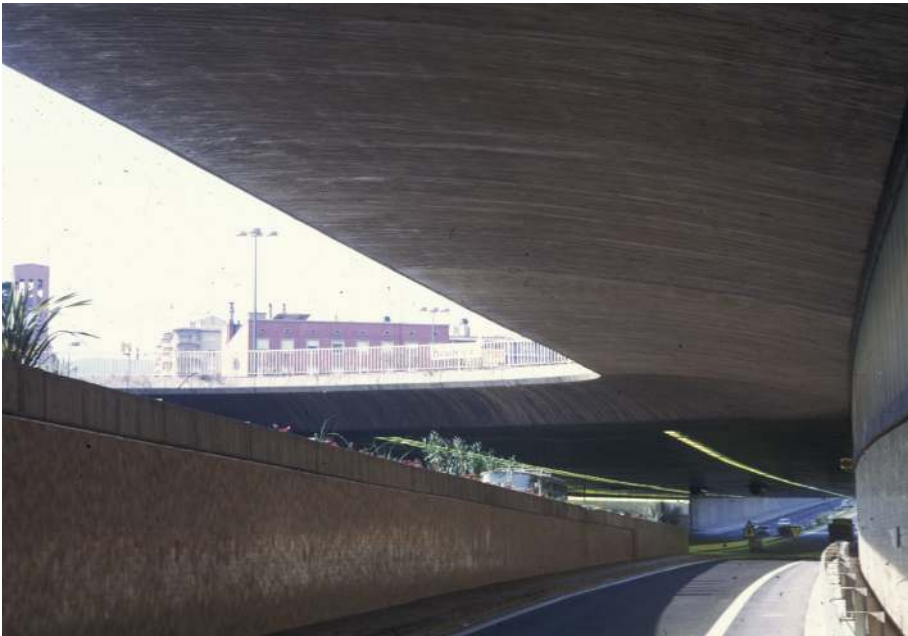
Paso bajo la Diagonal-Barcelona.
