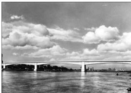
Puente de los Nibelungos
