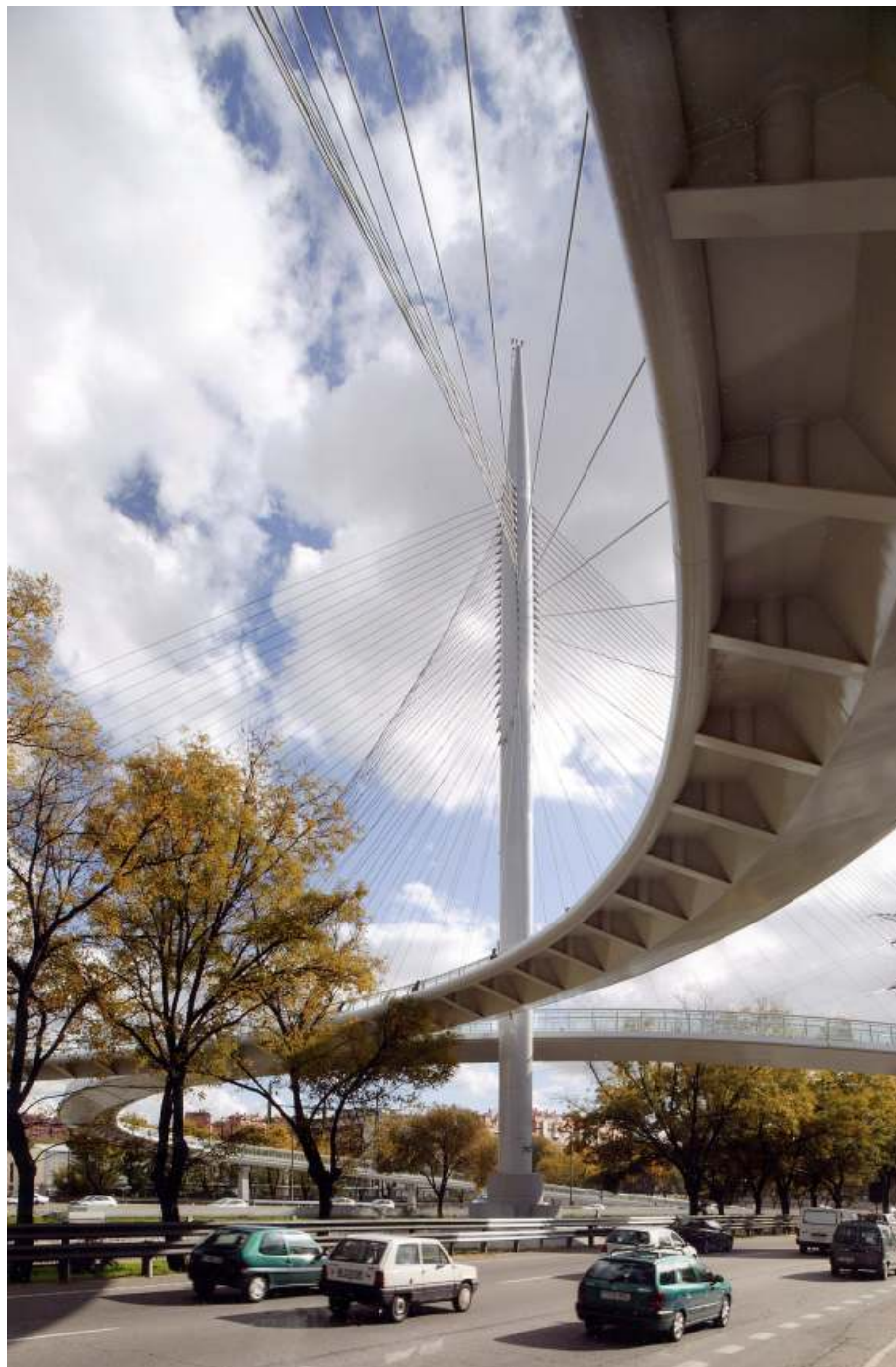
Pasarela de Manzanares
