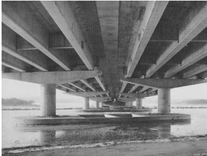
Puente francés de vigas prefabricadas
