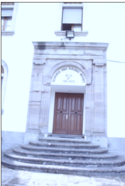
Francisco Echevarría Trápaga. Detalle de la portada de la antigua casa-hospital en Soscaño, Carranza.
