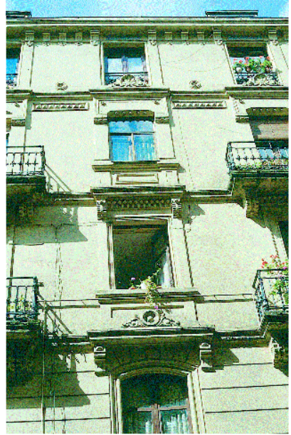
Fig. 9. Detalle de la fachada de la Casa de Toribio Larrea en Bilbao.
