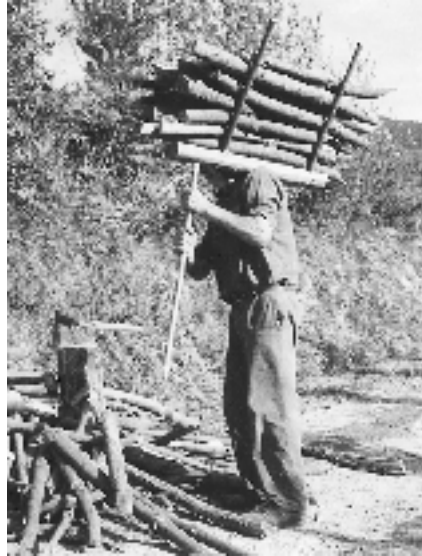
Fig. 2.- Acarreo de la leña "a hombros" por medio del "burro".
