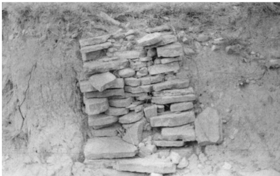
Foto 3. Muro de contención que estaba enterrado.
