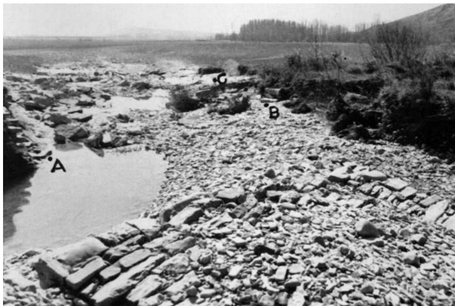
Foto 4. Derivación de la calzada que se dirige, con mucha pendiente, hacia el río.
