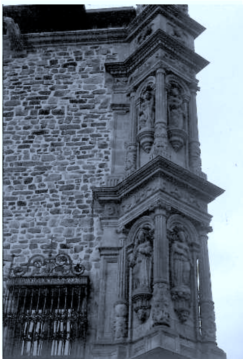
4. Colegio de Oñate, detalle de un pilar de la fachada.
