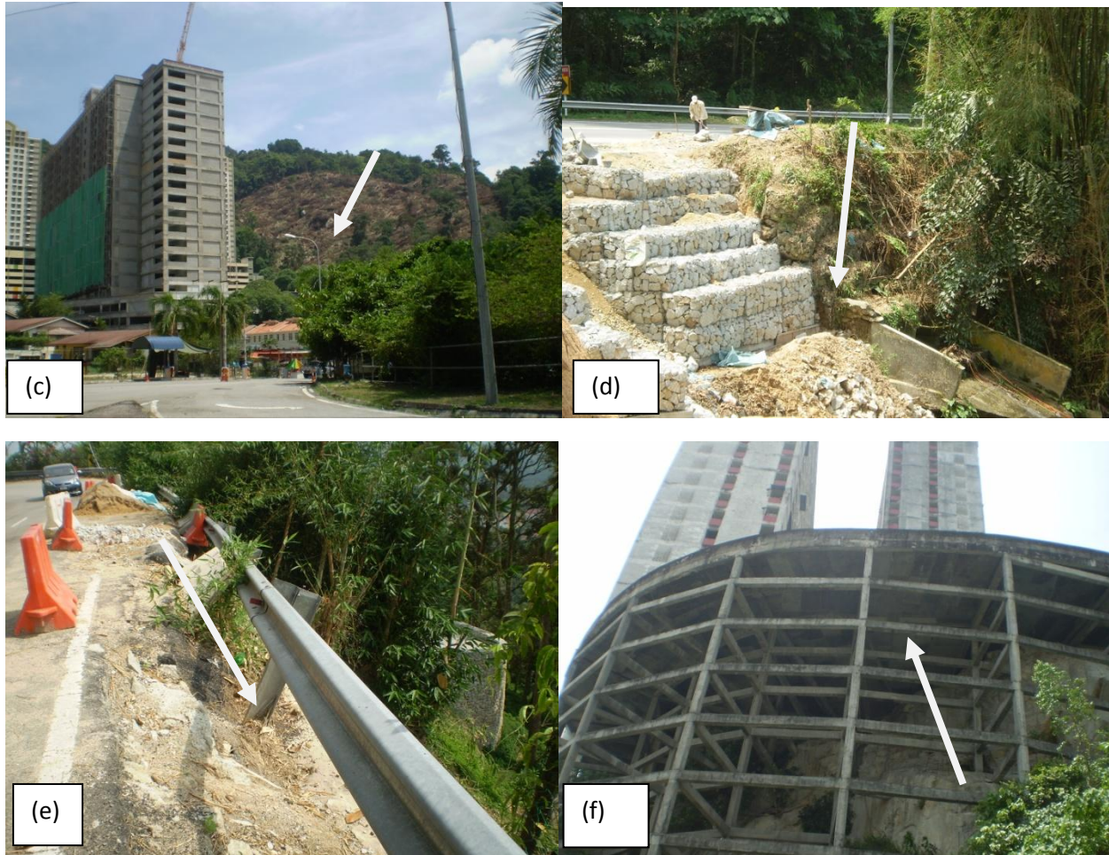
Rajah a) kedudukan cerun 45^{\circ} berdekatan dengan Taman Terubong Jaya. (b) cerun yang curam berdekatan berhadapan dengan perumahan Bukit Saujana (c) Pembinaan perumahan semakin bertambah walaupun lokasi kawasan tanah runtuh di Paya Terubong (d) cerun runtuh jalan ke barat daya. (e) jalan hampir runtuh di kawasan jalan ke Batu Feringghi. (f) Pembinaan tangki di cerun
