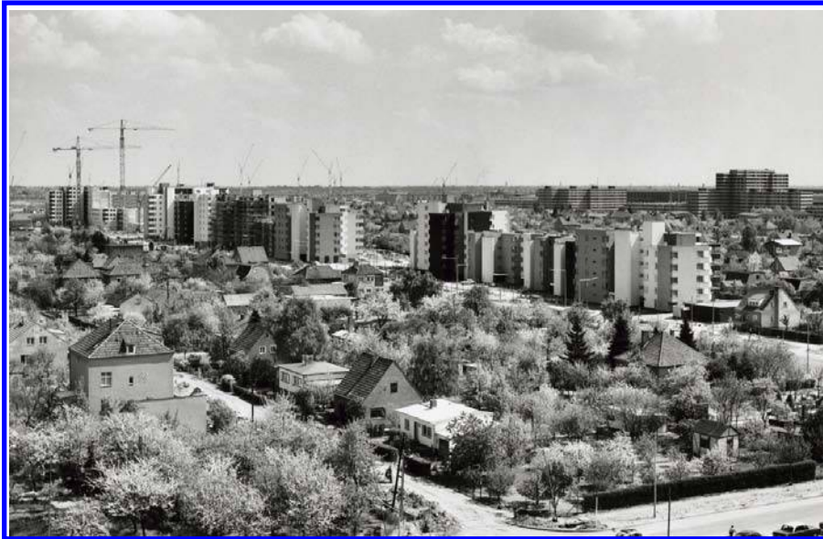
Figure 20 Construction of Märkisches Viertel, 1967 (Horst Siegmann; courtesy Landesarchiv Berlin)
