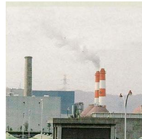
La centrale di Szczecin
