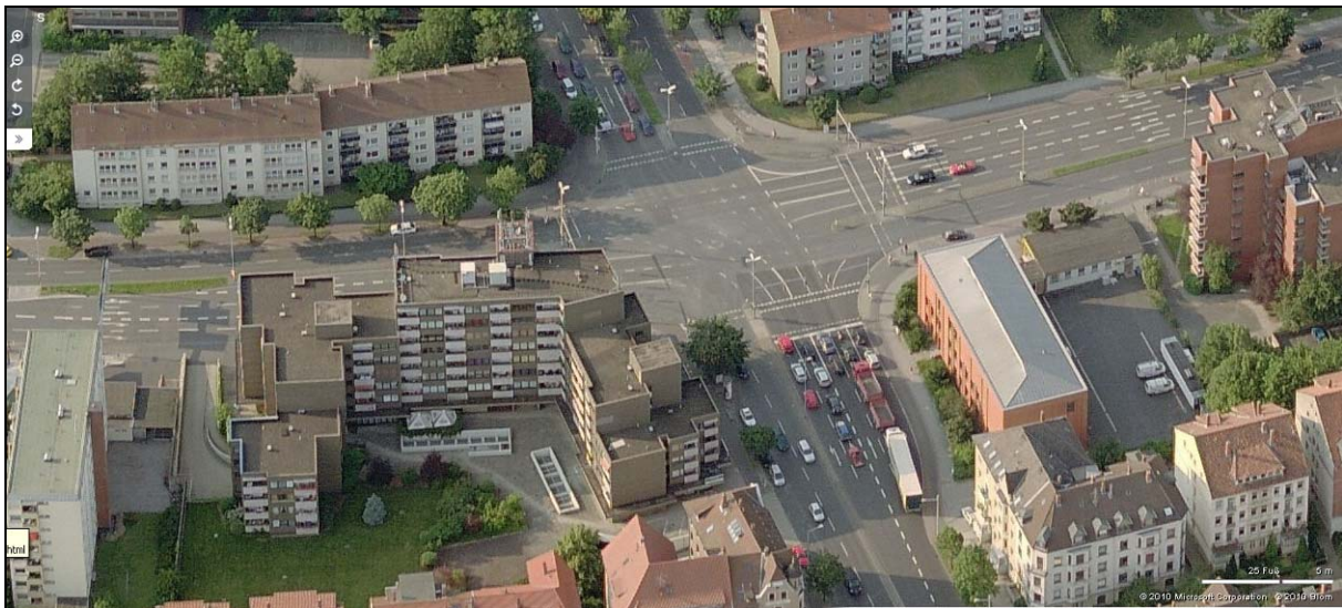
Abbildung 11: Zentraler Knotenpunkt des vorgesehenen Demonstrationsfeldes
