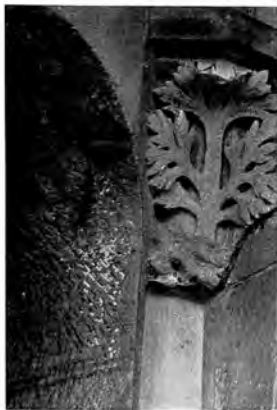
Abb. 124 Iben, Rippenkonsole am Treppenturm
