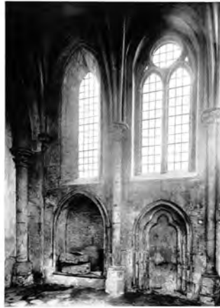
Abb. 120 Iben, Nördliche Längswand
