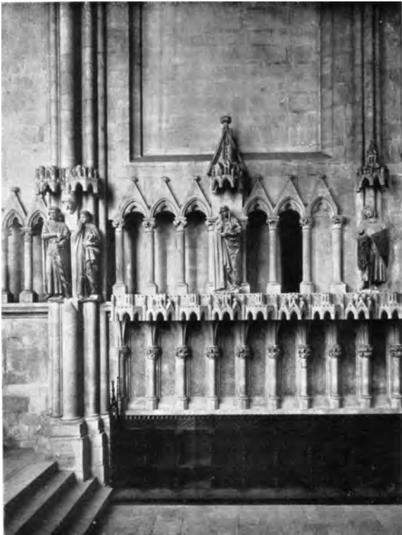
Abb. 245. Wandausschnitt aus dem Chorquadrum, nach dem Umbau. (Aus: Beenken 1939a, Abb. 100)
