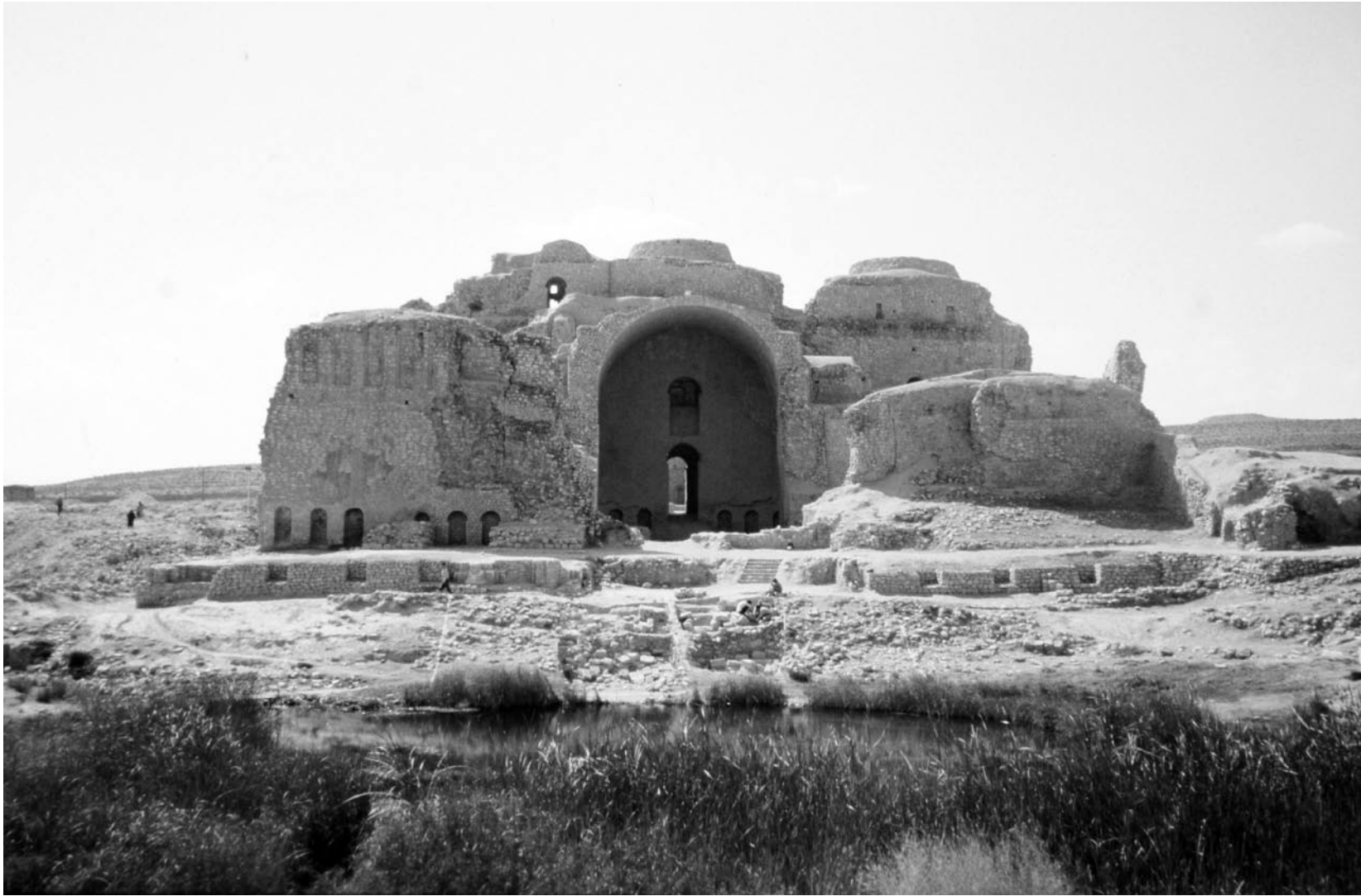
Firuzābād, Ateškade: Ansicht von Osten (Aufnahme: Verfasser)
