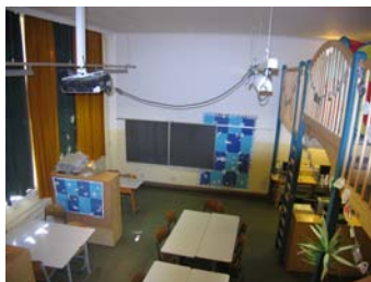
Deckenmontage Beamer (Nürnberg)
