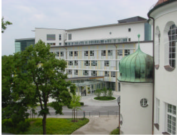
Abbildung 50: Außenansicht der Klinik
