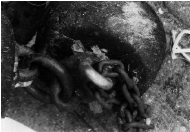
Abb. 5: Verschleißerscheinungen an einem Gummirollenelement
