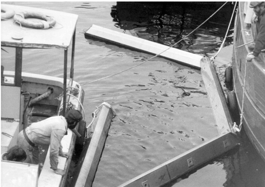
Abb. 17 : Demontage der IOR-Pontonrahmen im Wasser
