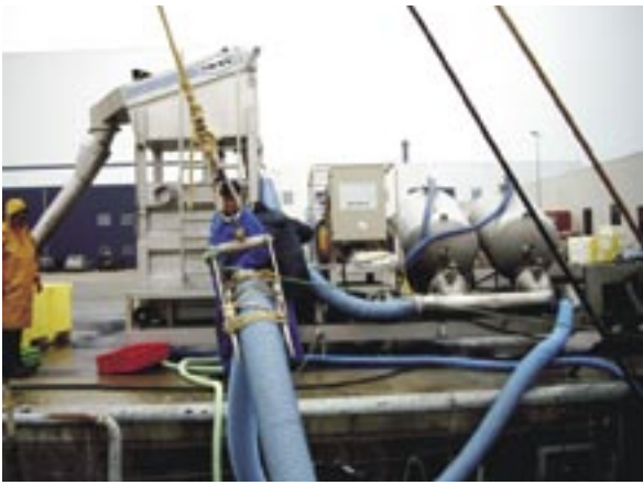
Abb. 2: Übergabe der Saugleitung und des Transportwasser-rückführschlauches - Hanging-over of the suction main and the return water hose.
