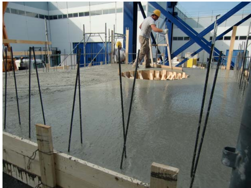
Figura 29.34. Getto della soletta e rasatura.
