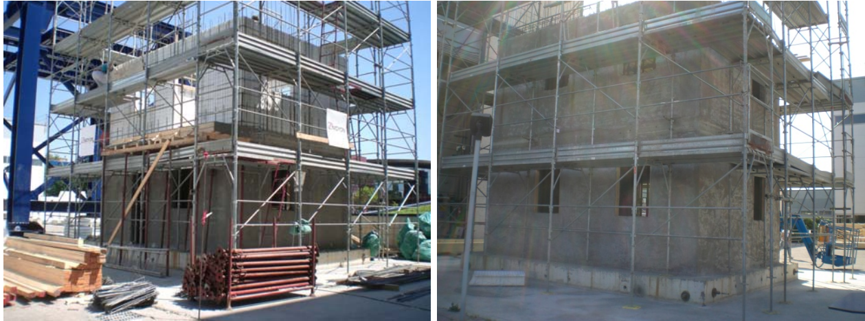
Figura 29.35. Realizzazione delle pareti del piano primo.
