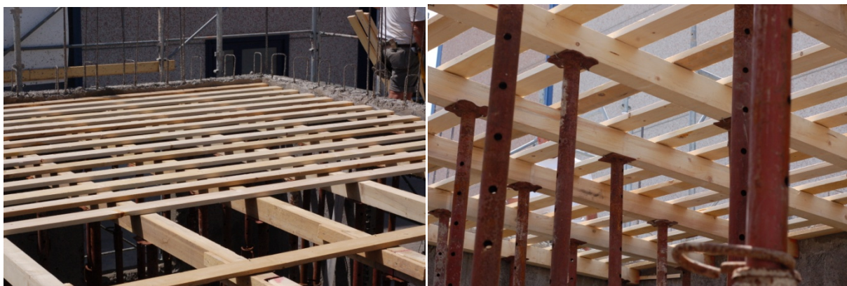
Figura 29.23. Posizionamento dei puntelli e le travi in legno di supporto del solaio.
