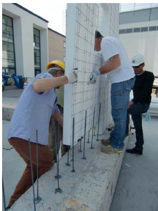
Figura 29.13. Posa in opera dei pannelli modulari con le barre di ripresa inserite all'interno della rete diffusa.
