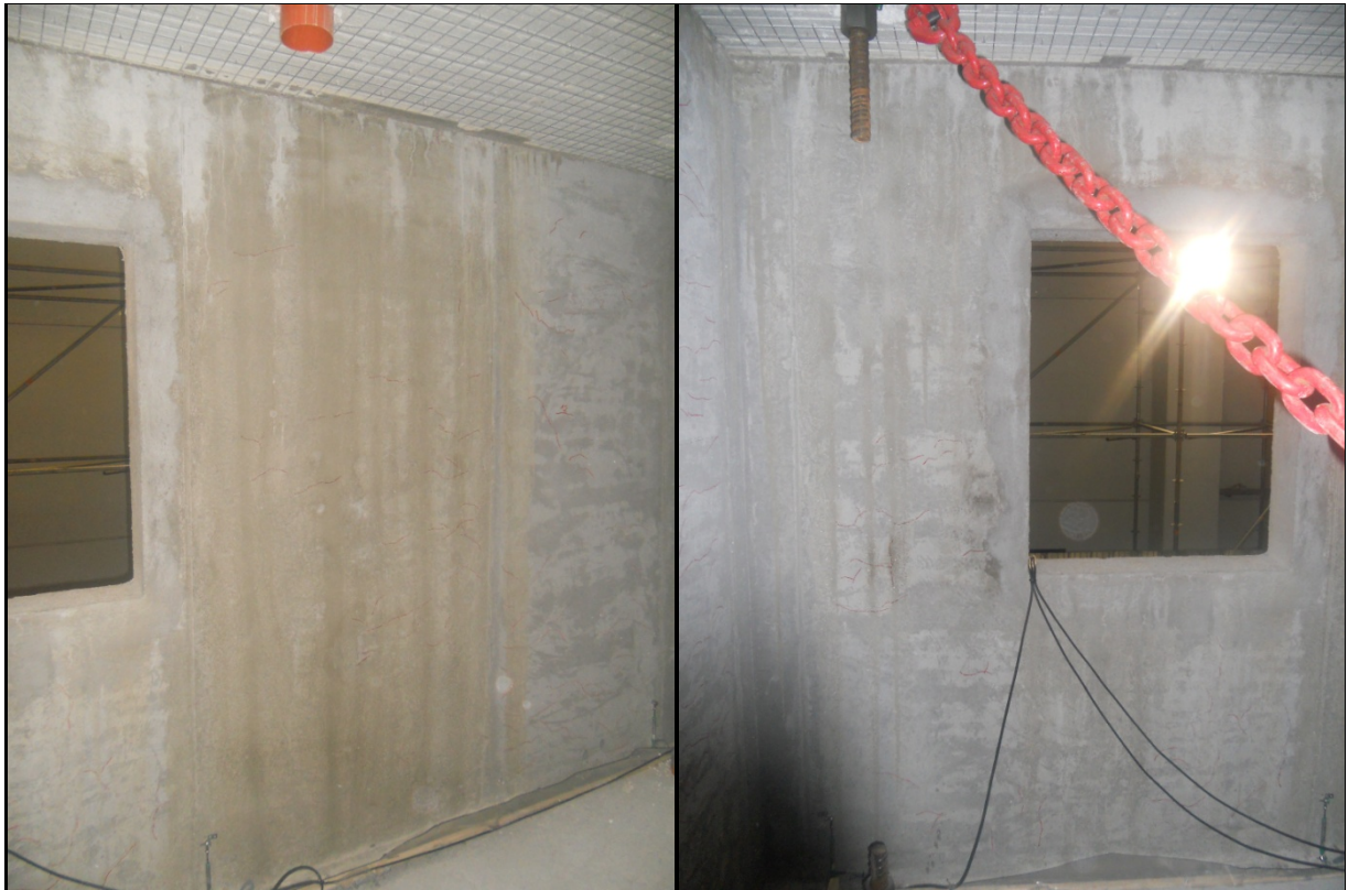
Figura 32.30. Foto delle pareti dopo il white noise a 0.5g: interno piano secondo
