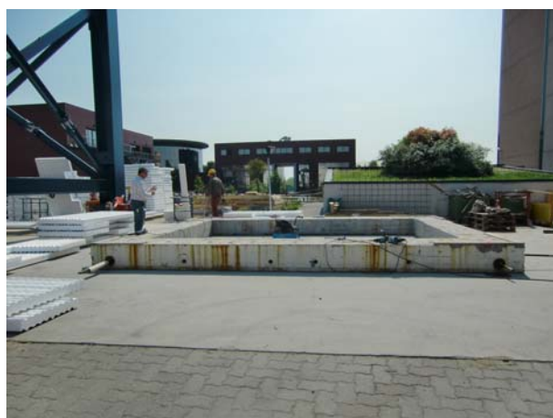
Figura 29.5. Fondazione della struttura.
