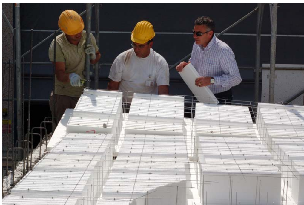
Figura 29.24. Posizionamento dei pannelli solaio NYF per la realizzazione del cassero per il solaio.
