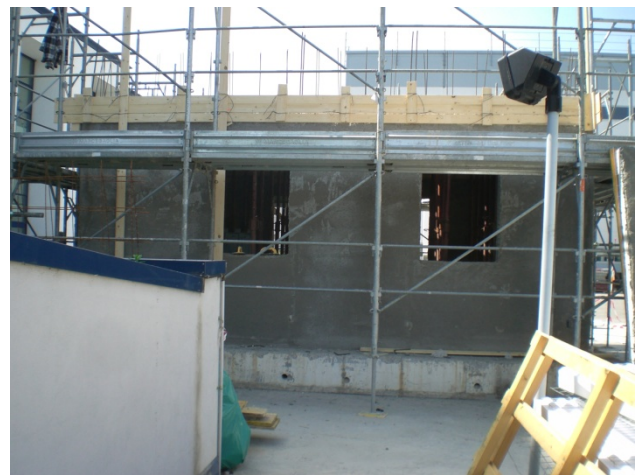
Figura 29.21. Applicazione del primo strato di calcestruzzo a “spritz beton”.
