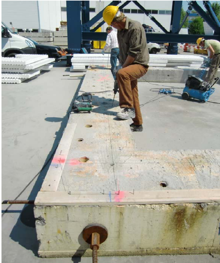
Figura 29.6. Tracciamento ed esecuzione dei fori per le riprese verticali emergenti dalla struttura di fondazione.
