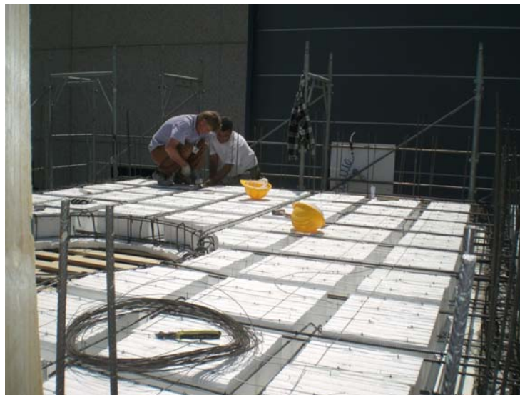
Figura 29.32. Cassero per il solaio completato con le armature aggiuntive.
