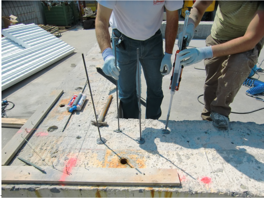
Figura 29.8. Agganci chimici per riprese verticali \phi 8 passo 30 cm.
