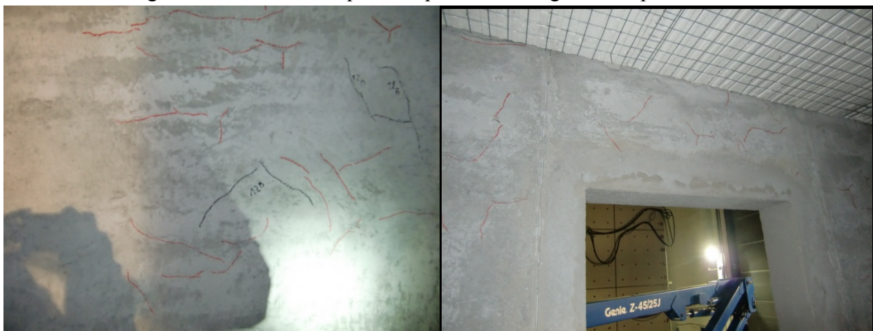
Figura 32.35. Foto delle pareti dopo il test a 1.2g: interno piano secondo
