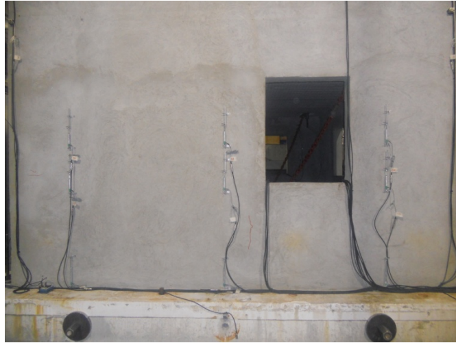
Figura 32.32. Foto delle pareti dopo il white noise a 0.5g: esterno piano primo.
