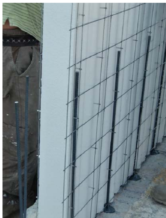
Figura 29.13. Posa in opera dei pannelli modulari con le barre di ripresa inserite all'interno della rete diffusa.
