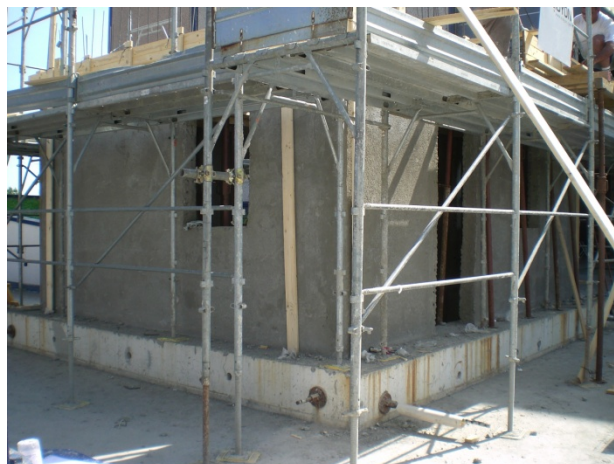
Figura 29.22. Le parete sandwich del piano terra, dopo l'applicazione del secondo strato di calcestruzzo, prima della rasatura di finitura.
