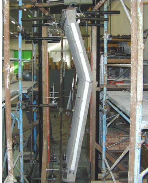
Figura 10.7. Parete 4 - Vista dell'elemento rotto in due parti in seguito al raggiungimento del carico di rottura.
