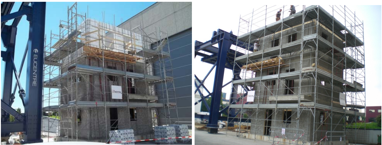
Figura 29.36. Realizzazione delle pareti del piano secondo.
