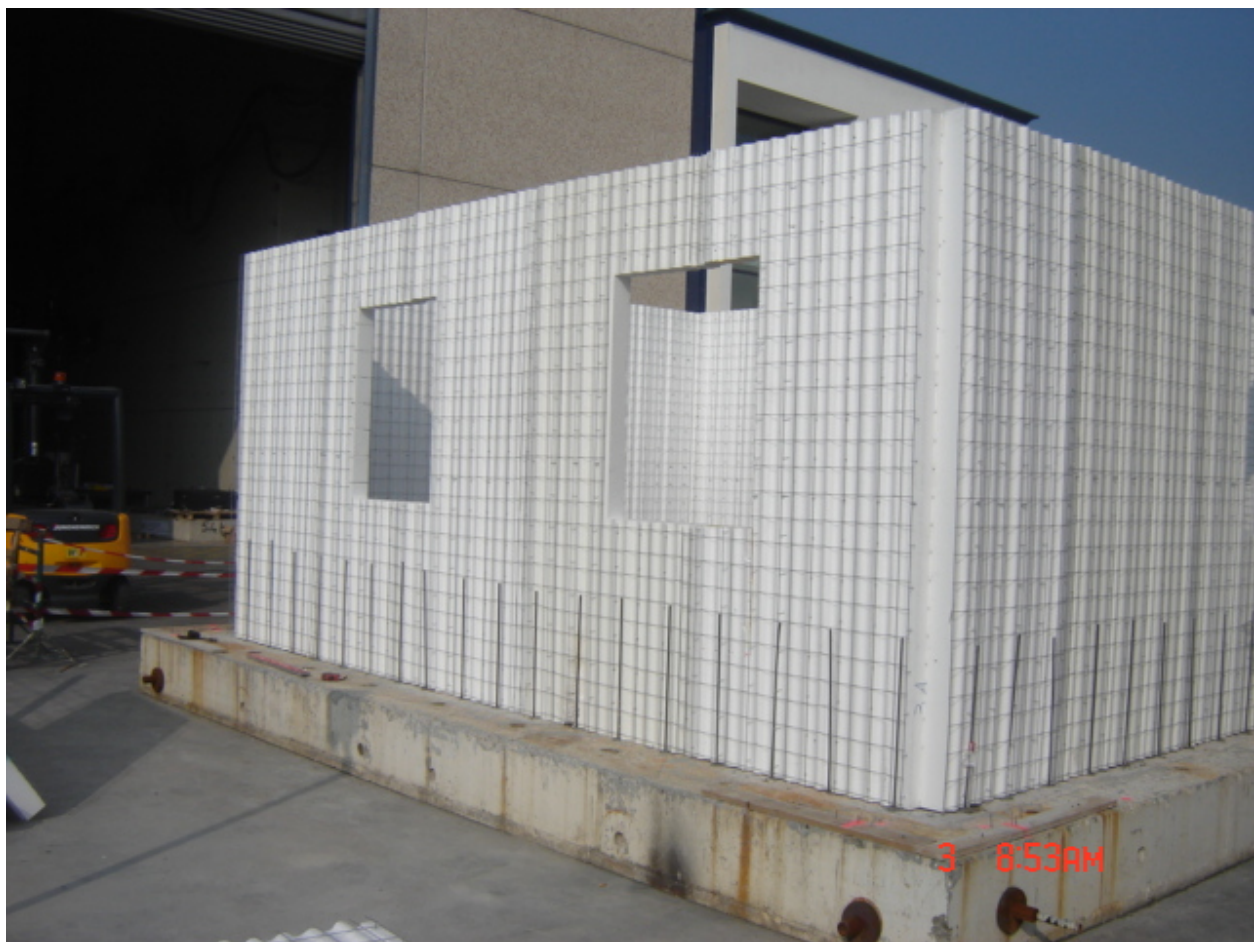
Figura 29.12. Pannelli modulari assemblati per costituire la parete di supporto.
