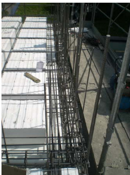
Figura 29.28. Cordolo del solaio del primo piano.
