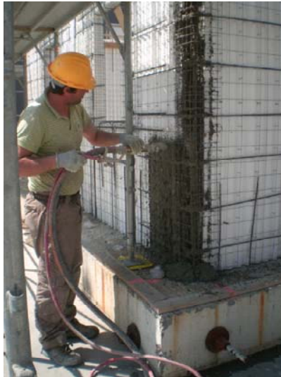
Figura 29.21. Applicazione del primo strato di calcestruzzo a “spritz beton”.
