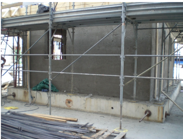
Figura 29.21. Applicazione del primo strato di calcestruzzo a “spritz beton”.
