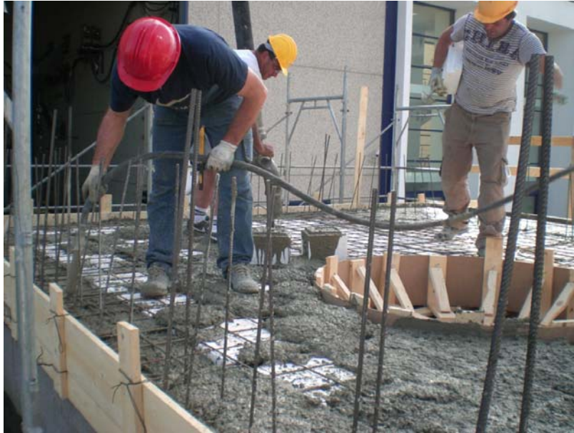
Figura 29.33. Getto in corrispondenza del cordolo perimetrale e dei travetti.
