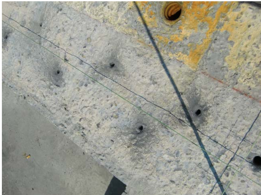
Figura 29.7. Riprese verticali per i \phi 8 passo 30 cm e per i \phi 16 .
