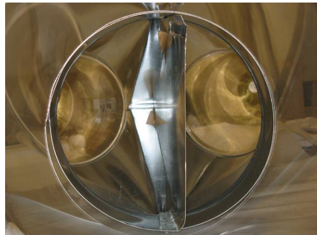
Fig. 21: setto divisore della parte centrale.
