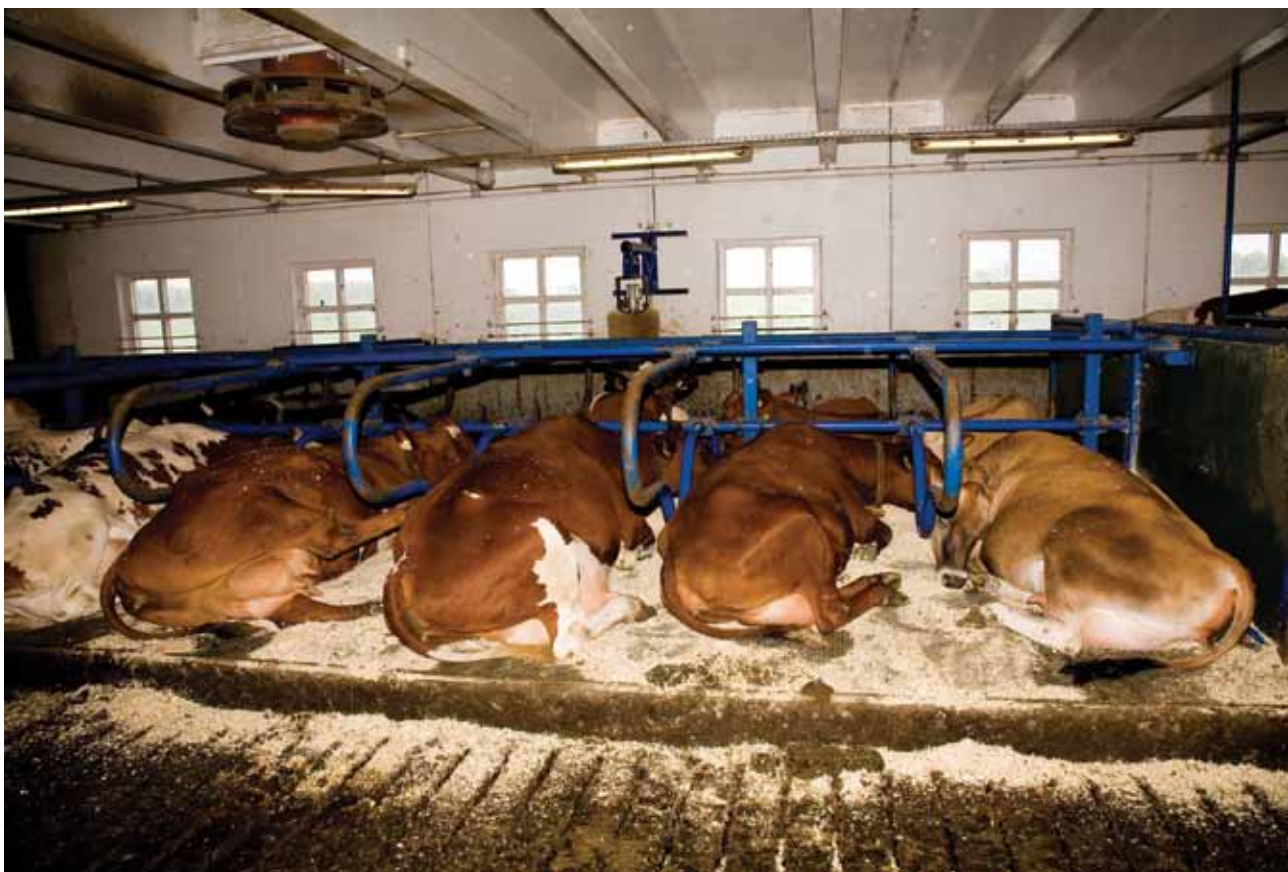
Løsdrifts fjøs med to rekker liggebåser plassert mot hverandre. Det er madrasser i liggebåsene og spaltegulv i gangarealet. (Foto: Vera Gjersøe)
