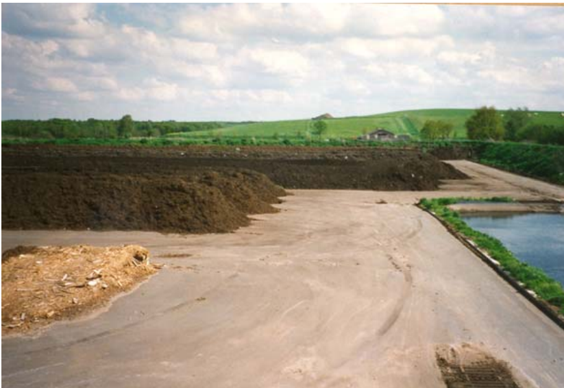
Foto 6. Percolaatbassin voor opvang van (regen)water.
