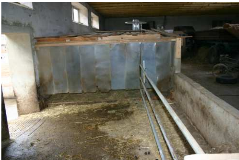
Abb. 60) AZ07: Kistenstall für Sauen und Ferkel, links Auslauf, rechts Gruppensäuge- bzw. Aufzuchtbucht, mit Ferkelschlupf (ganz rechts) (Foto: BAT e.V.)
