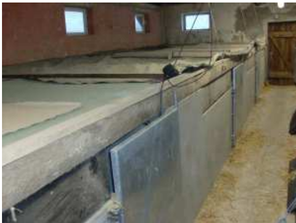
Abb. 33) AZ04: Kistenstall mit Stallgasse
