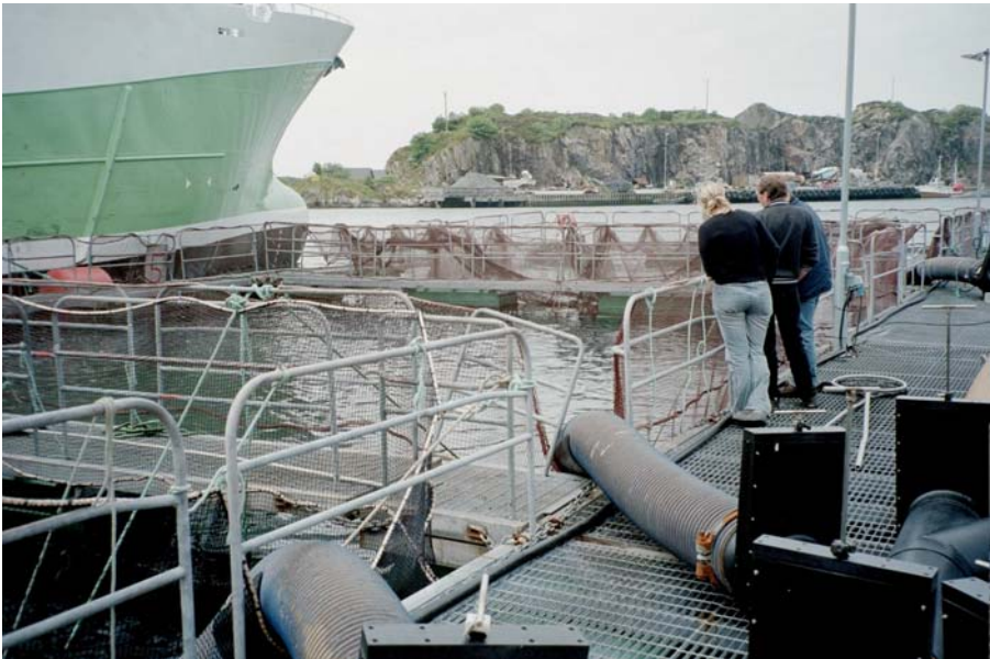
Bild 4: Hälterungsbecken mit Pumpen
