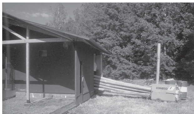
Bild 1: Mobilt hönshus under uppvärmning med byggtork.
