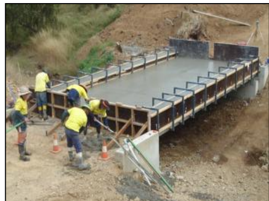
(d) Finishing work on the fresh concrete
