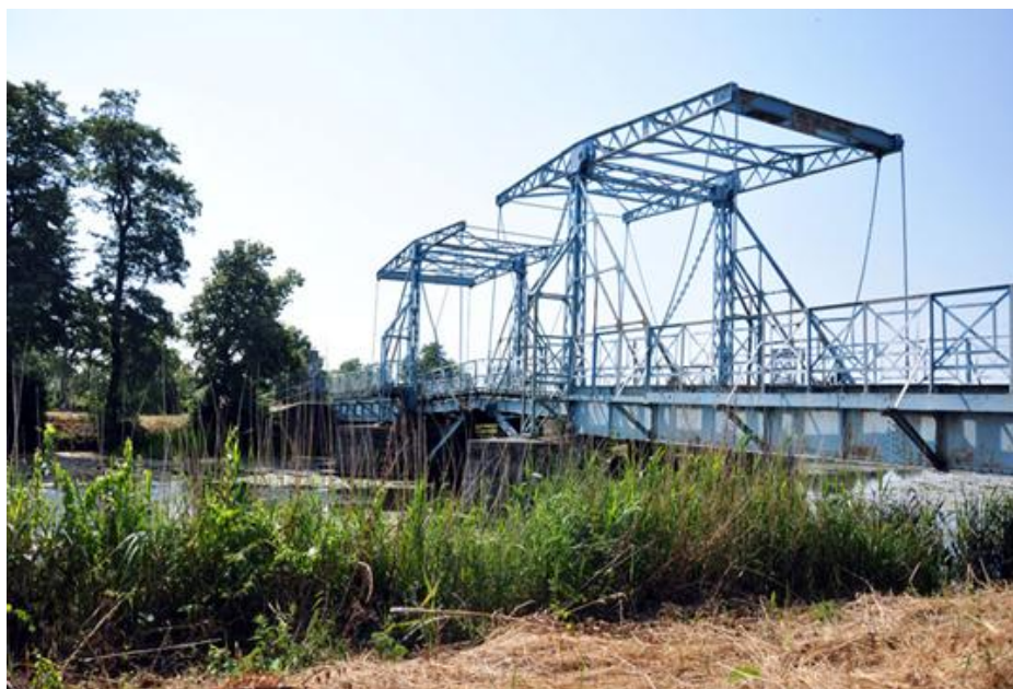
■ Fot. 1. Most zwodzony nad rzeką Tyną, fot. M. Brennenstuhel, 2010 r.
