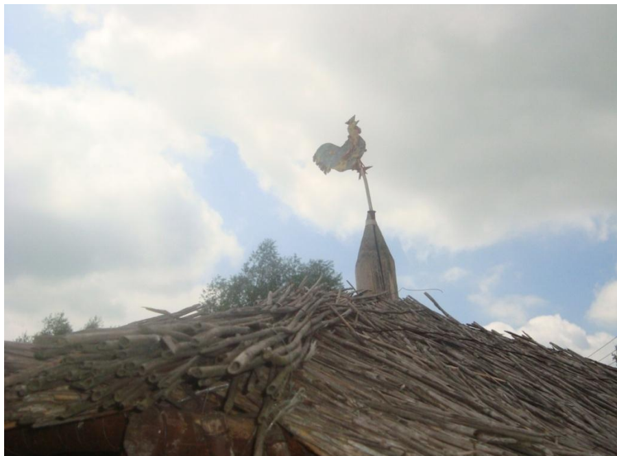
Il. 1. Dach altanki, Stare Pole, 2010, fot. E. Bajda.
