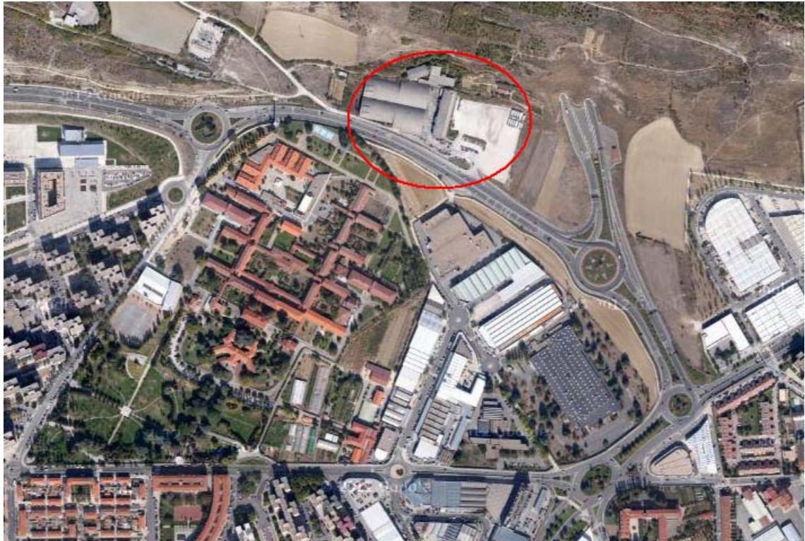
Fig: Ubicación de la cochera de villavesas de Pamplona
