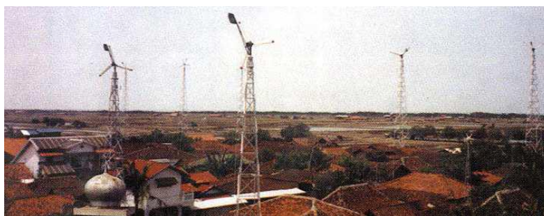
Figura 2.4- Ejemplo de instalaciones de micro-generación.
