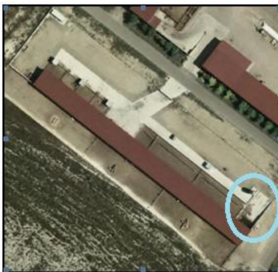
Figura 46: Situación de la fosa exterior de estiércol en la granja Ganados Txomin. (Fuente: SITNA).
