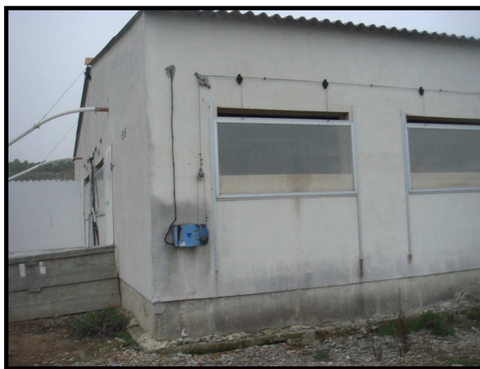
Figura V.11: Sistema de ventilación en las naves de la granja de Ursua Sobejano S.L. (Fuente: elaboración propia).
