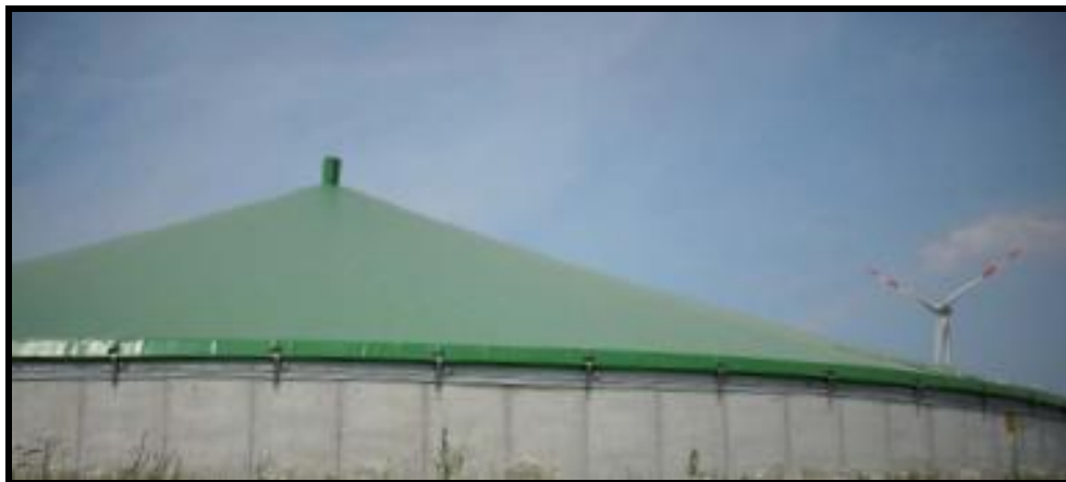
Figura 54: Cubierta de membrana de doble hoja. (Fuente: www.sattler-ag.com)
