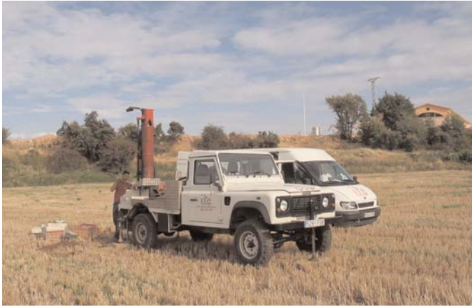
Fotografía 1.- Ejecución del sondeo mecánico S-1.
