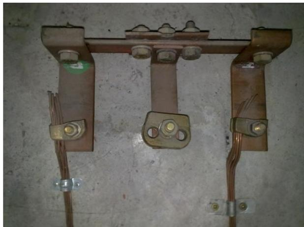
**Fig.2. 15 Conexión a tierra del taller**
