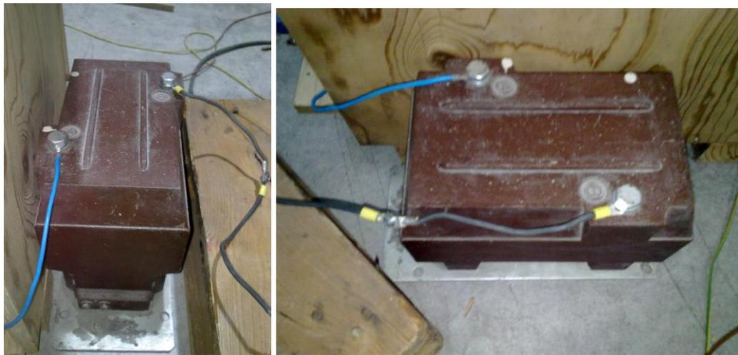
Fig.2. 6 Trafo Medida usado como  $L_c$
