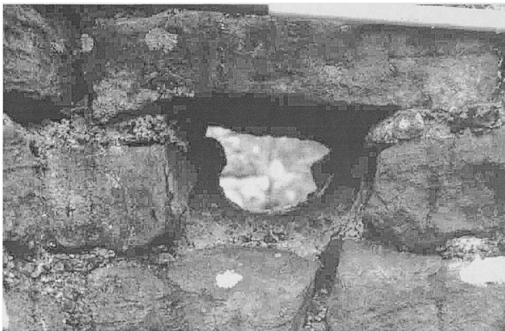
a. Putlog hole, wall 10
