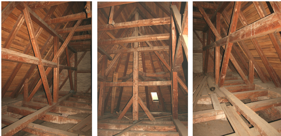
Obr. 14, 15, 16: Severní strana krovu lodi, podkroví presbytáře a jižní stran krovu lodi, foto, 2012
