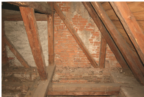
Obr. 13: Podkroví lodi, pohled na západní štít se zazdívkou montážního otvoru, foto, 2012
