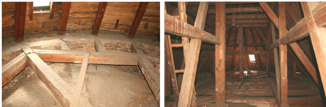
Obr. 11, 12: Podkroví presbytáře – systém výměn a krátčat nad konchou, pohled z podkroví lodi do podkroví presbytáře, foto, 2012
