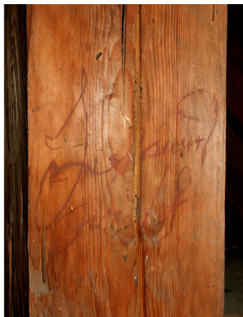
Obr. 7, 8: Datace 1799 na 5. vazném trámu od západu a jméno tesaře Franz Haudorf? na sloupku 6. Vazby krovu, foto, 2012
