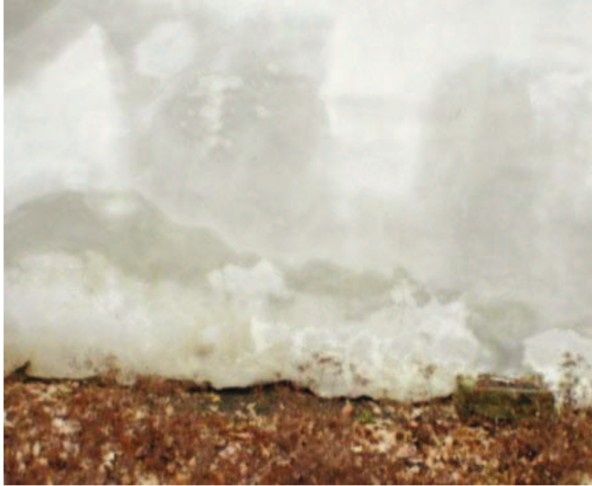
Obr. 8: Vlké zdivo z důvodu vzlínivosti od podloží
