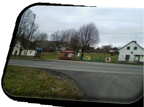
Obr. 3 Pohled na stávající objekt od silnice I/3, vlastní zdroj
