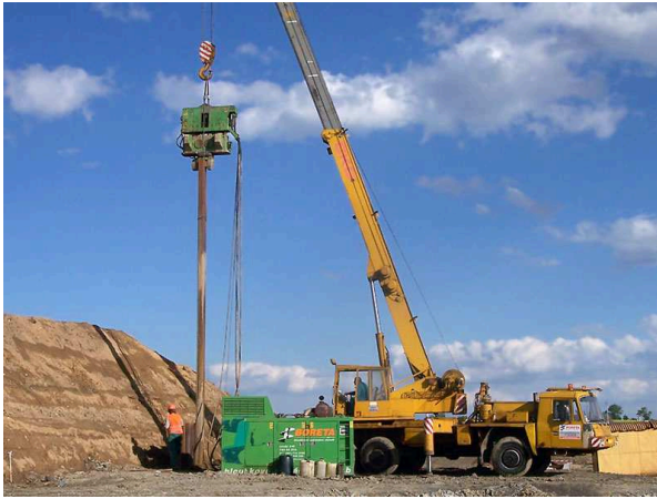
Obr. 13 Vibrační kladivo na jeřábu [19]
