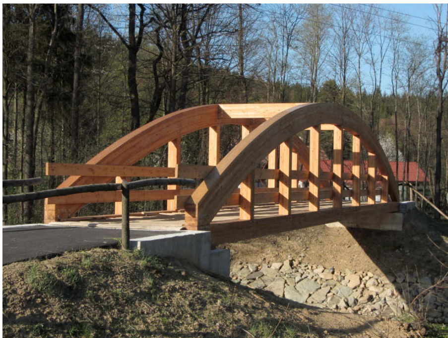
Obr. 2.3-1 – lávka na cyklostezce v Dolní Lomné přes řeku Lomná
