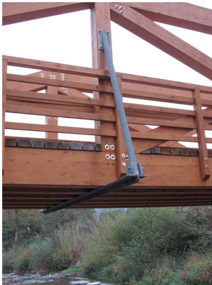
Obr. 2.3-6 – příčné ocelové ztužidlo
