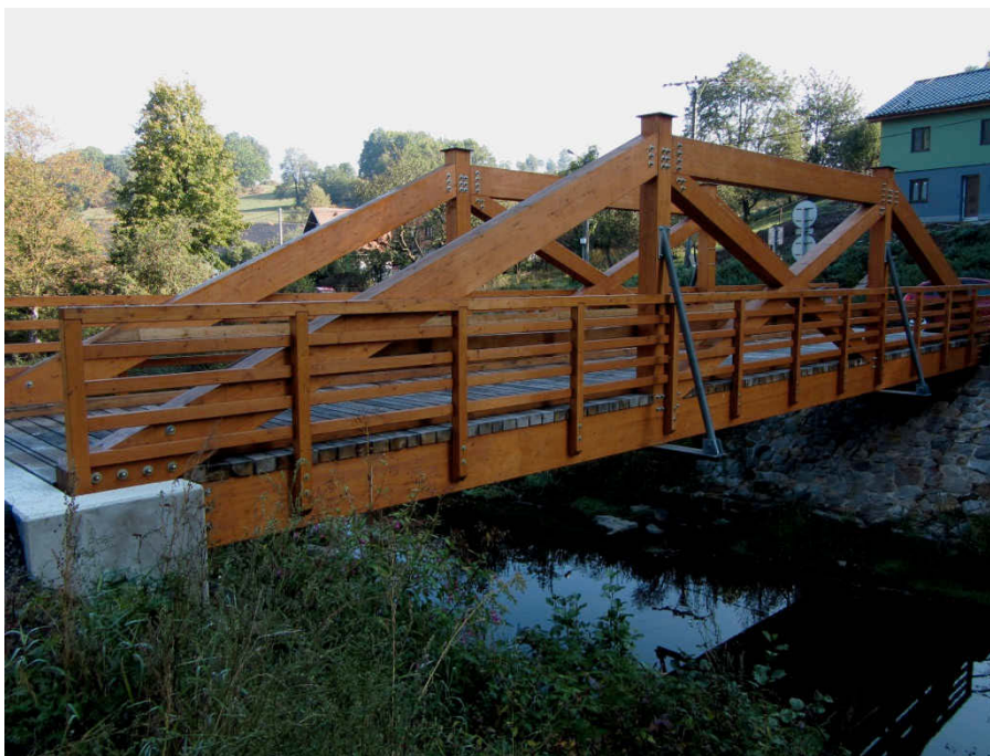
Obr. 2.3-4 – dřevěný most v Žilině u Nového Jičína přes řeku Jičínka
