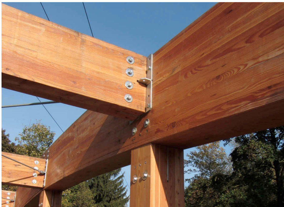
Obr. 2.3-3 – ocelové spojovací prvky
