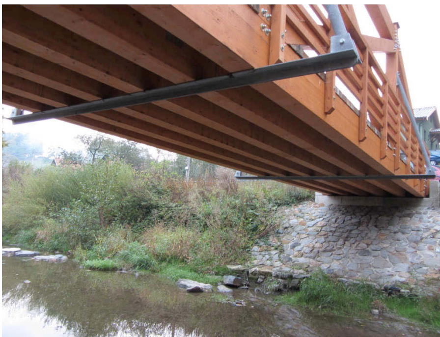
Obr. 2.3-5 – šest kusů přímých nosníků LLD průřezu 240 mm × 450 mm
