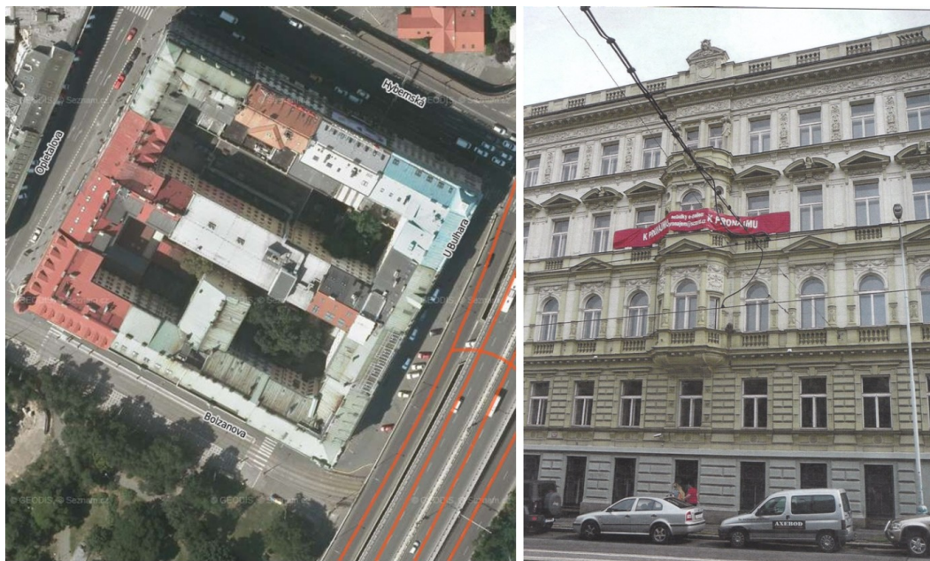
Obr. 4 Letecký pohled na řešený objekt + pohled z ulice Bolzanova, www.mapy.cz
