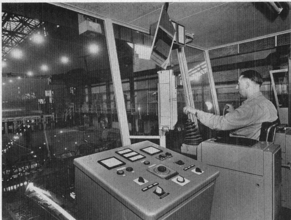
Poste de commande DO-62 du train dégrossisseur. (Koninklijke DEMKA Staalabrieken N.V.)
