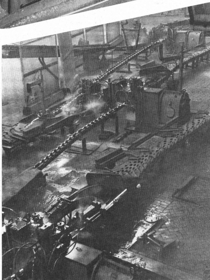
Vieux train à fil de Haspe, serpentant à la première cannelure de la ligne intermédiaire. (Klöckner-Werke AG)
