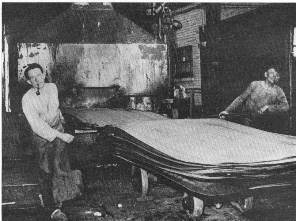
Tôlerie de Liège. Sortie du four continu. Tôles moyennes. Empilage des tôles recuites. (S.A. Espérance-Longdoz)
