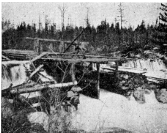
中原正虎『実用 伐木運材法』184 頁、第五十八図。 扉を吊上げて開放した情況。
