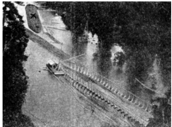
同書、198 頁、第六十図。右下のエリヤで丸太を鎖で結束し船型の巨大筏を組み、下流に放つ。左上の×印がそれ。
