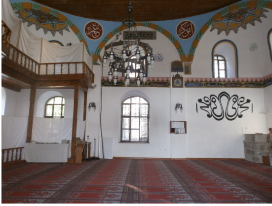
Resim 33 Tabakhane Camii doğu cephe
