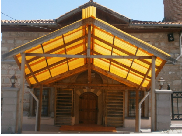
Resim 6 Saray Camii kuzey cephe
