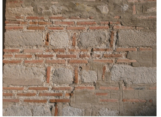
Resim 2 Saray Camii duvar örgüsü detay
