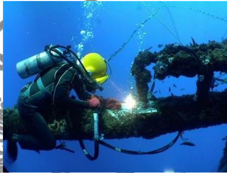
Gambar 2.11 Posisi pengelasan di bawah tangan
