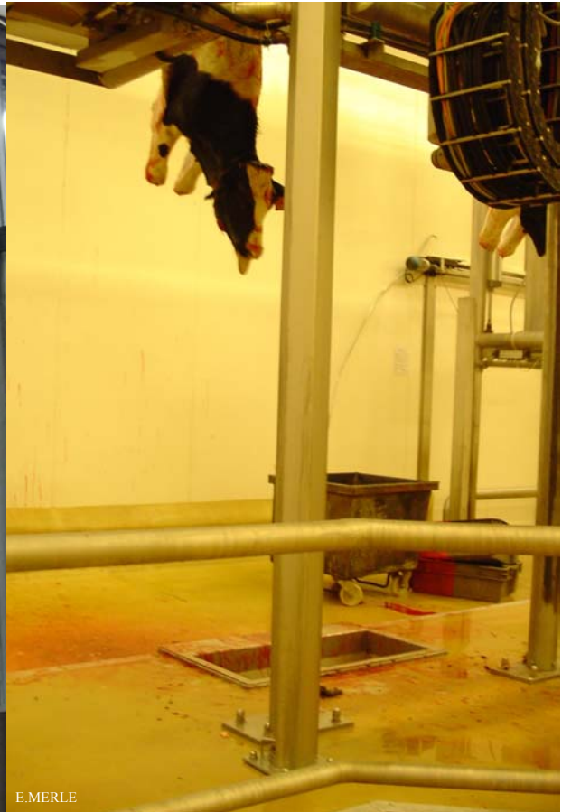
Photo 5 : Mécanisme d'évacuation du cuir par une ouverture conduisant à un tunnel sous le sol. Ceci permet la séparation du secteur souillé et du secteur propre.
